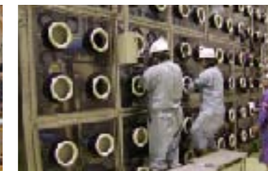
グローブボックスによるコンデンサの解体作業
