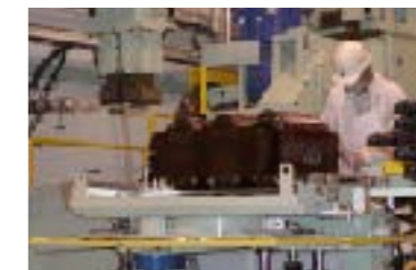
トランスの解体作業
